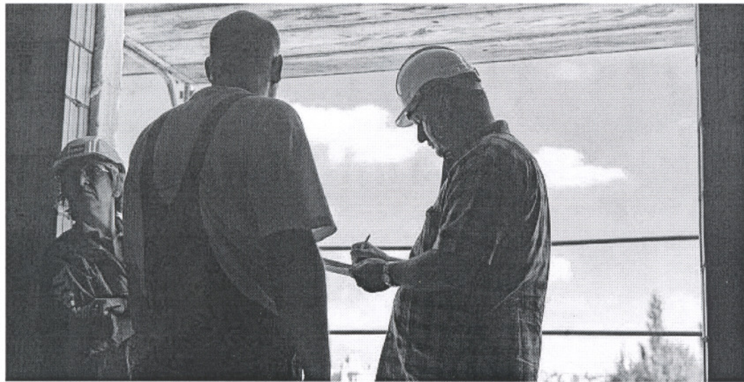
Baustellenkontrolleure überprüfen die Einhaltung der Gesamtarbeitsverträge – etwa hinsichtlich Lohn und Arbeitszeit. Foto Keystone
